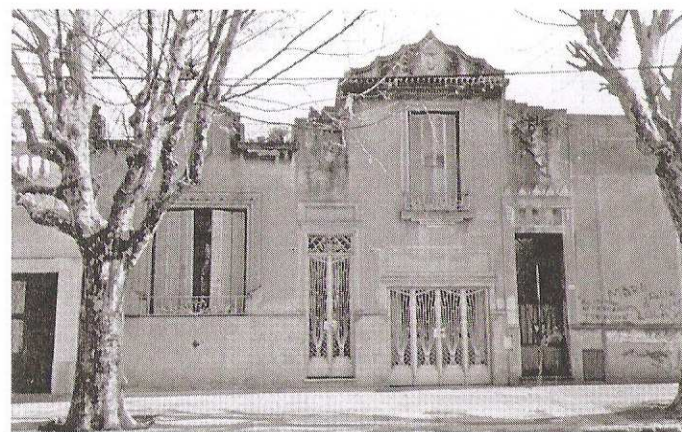
Figura 20. Viviendas multifamiliares. Argerich 1492, Buenos Aires. Scofienza Hnos., M. M. Obras. No existía aún la ley de propiedad horizontal. Un propietario construía casas en un mismo lote las cuales eran alquiladas. Era un modo de inversión. Fuente: Carlos Di Pasquo.
