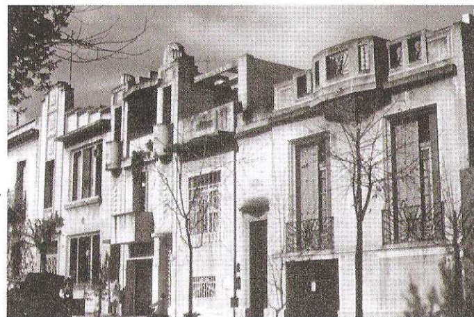
Figura 19. Obras de Greco Hnos., en la calle Cochabamba. Fuente: Carlos Di Pasquo.
