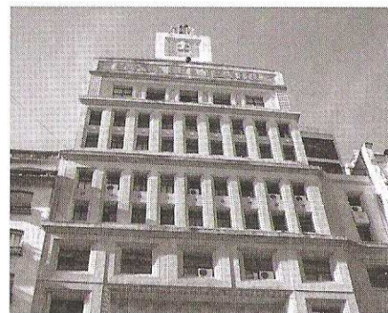
Figura 12. La Casa del Teatro. Av. Santa Fe 1243, Buenos Aires. Arq. Alejandro Virasoro, 1927. Fuente: R. Fiadone.
