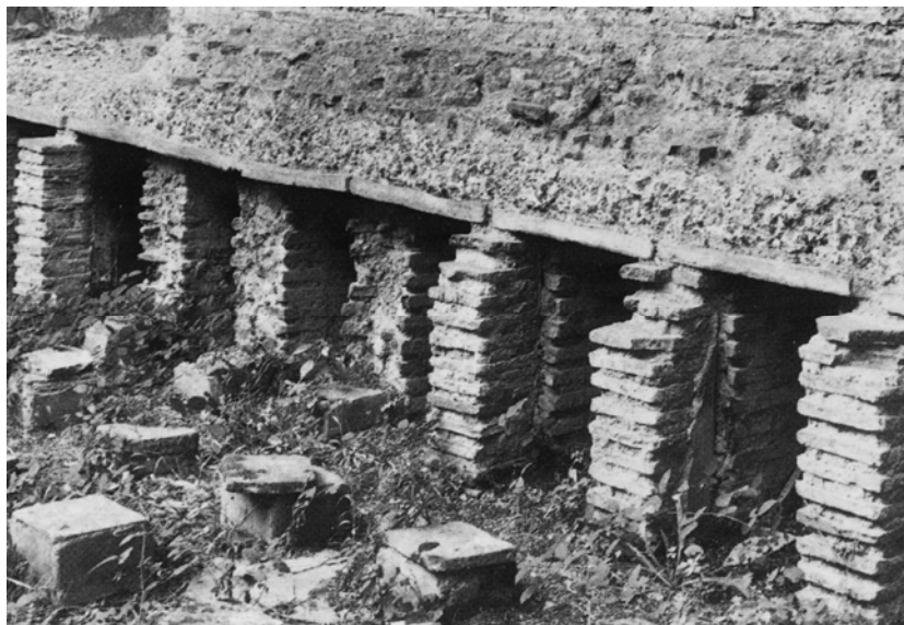
Sistema de calefacción de la terma
